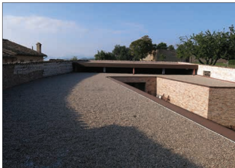
Il tetto dell'Auditorium.
